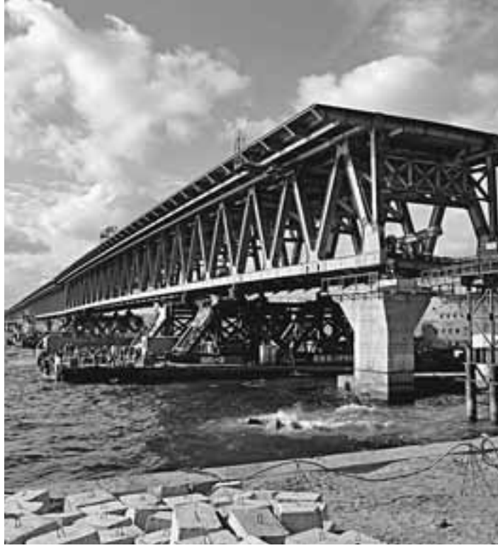
После установки 220-метровой машины до берега осталась всего один шаг длиной 66 метров.
